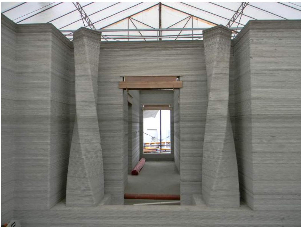
Foto: Lewis Yakich's Hotel in the Philippines. Opført af Andrey Rudenko. Eksempel på en 3D printet søjle som roterer om sin lodrette akse.
